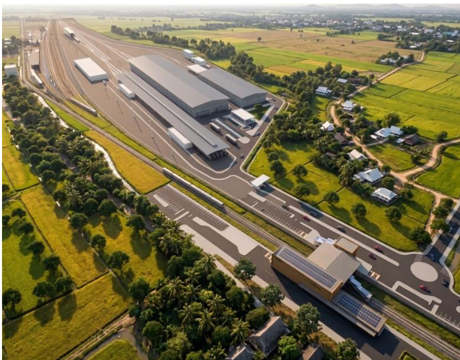
รูปที่ 6.2-11 แสดงลักษณะศูนย์ซ่อมบำรุงฯ บริเวณสถานีท่าแฉลบ
